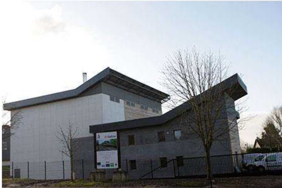
Figure 70 : Chaufferie bois-énergie du réseau de chaleur d'Abbeville.
